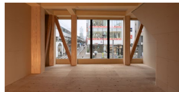
2階 内観 (内装工事前)
