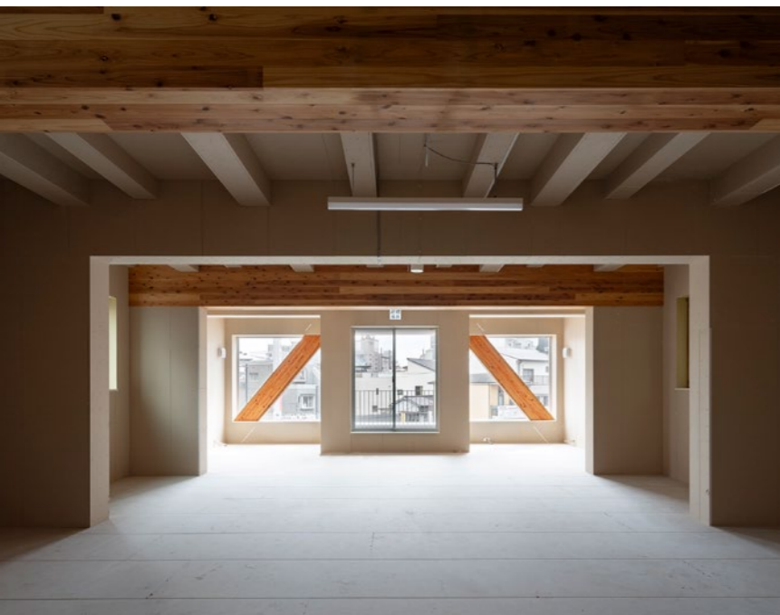
3階 内観(内装工事前)
